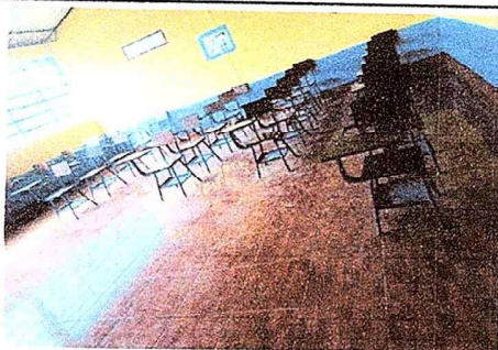
Foto 5: Piso Ceramico de 1 aula.
