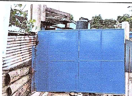
Foto 6: Instalación de porton.
